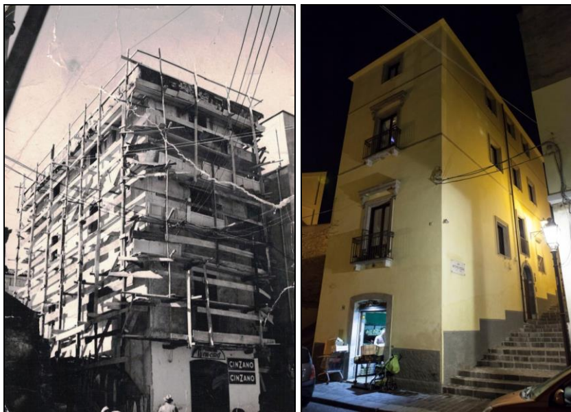
La casa di Catanzaro in fase di ristrutturazione, nel 1958, e come si presenta oggi
